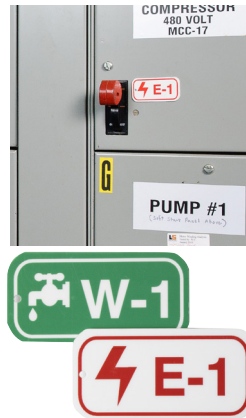
Paso 3: Identificar y marcar todos los puntos de control de energía.
