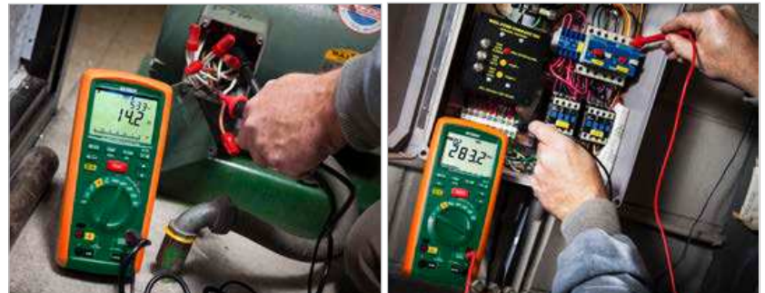
Comprobación del voltaje en un torno y prueba de aislamiento en el motor de la bomba.
