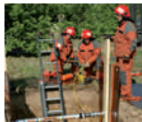
- Rescate en zanjas
